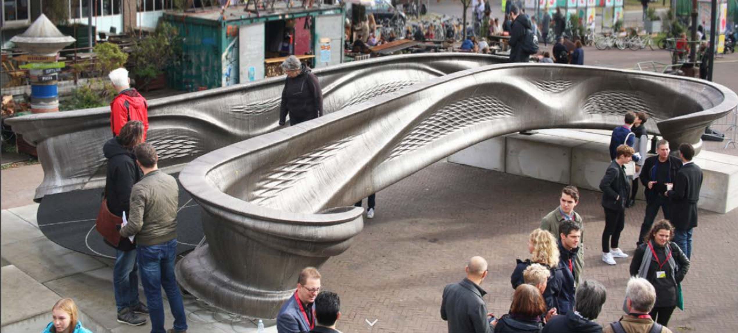
4. 粉末燃結方式 材料: 鉄
