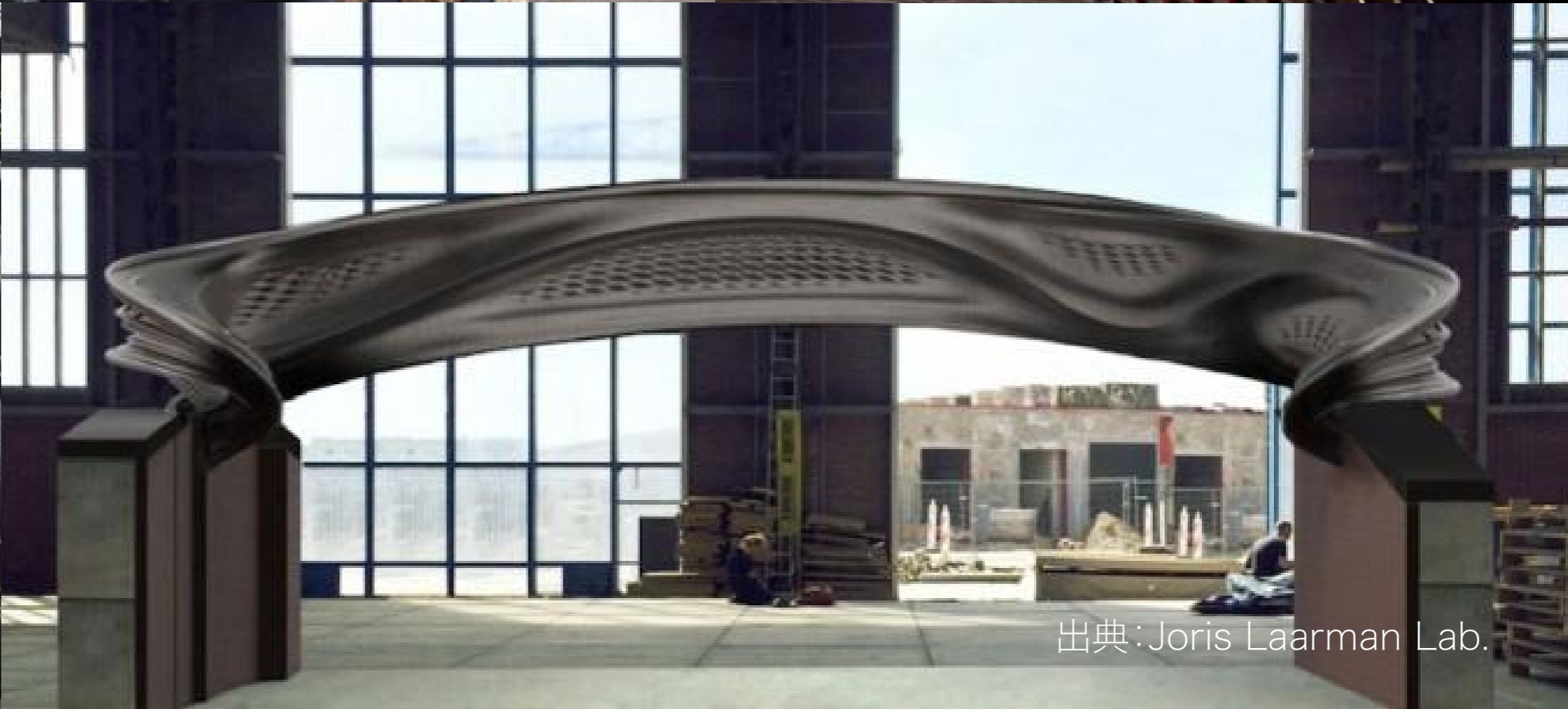
4. 粉末燃結方式 材料: 鉄
